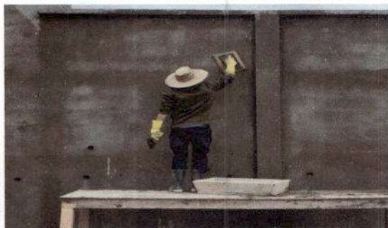
Foto 5: Repello en muro
