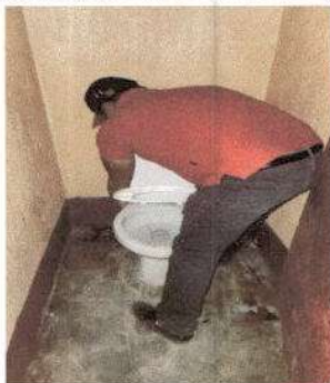
Foto 3: Reparación de Accesorios de Inodoro
