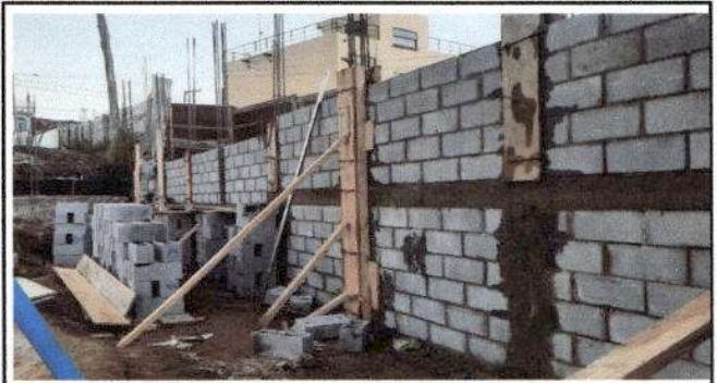
Foto 4: Sustitución de muro perimetral de block con cimiento, columnas y soleras intermedias
