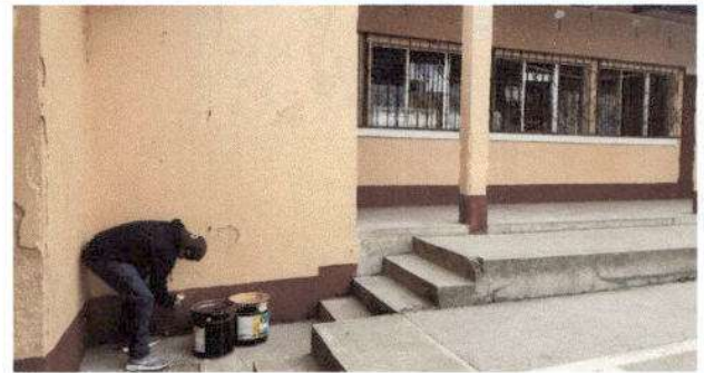
Foto 2: Pintura en muros exteriores
